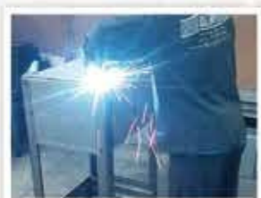
Serviço de Caldeira c/ Soldas MIG
